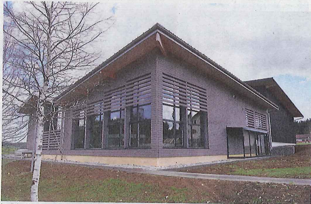
Installations de chauffage à distance au bois et fromagerie toute neuve: au nord du village, ce complexe à douze millions sera inauguré lors d'une grande fête populaire ce week-end à La Brévine. RICHARD LEUENBERGER
