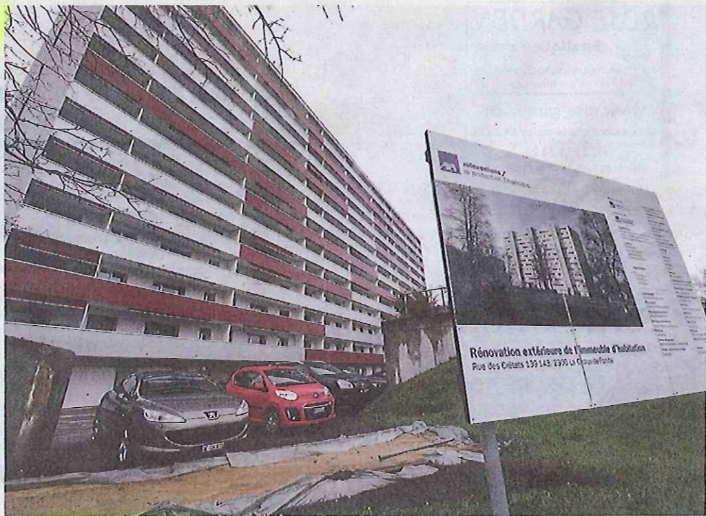
Rue des Crêtets, à La Chaux-de-Fonds, un assainissement complet d'un immeuble de 132 logements a permis d'éliminer l'utilisation de l'énergie fossile et d'économiser plus de la moitié de l'équivalent de 130 000 litres de mazout par année. CHRISTIAN GALLEY
